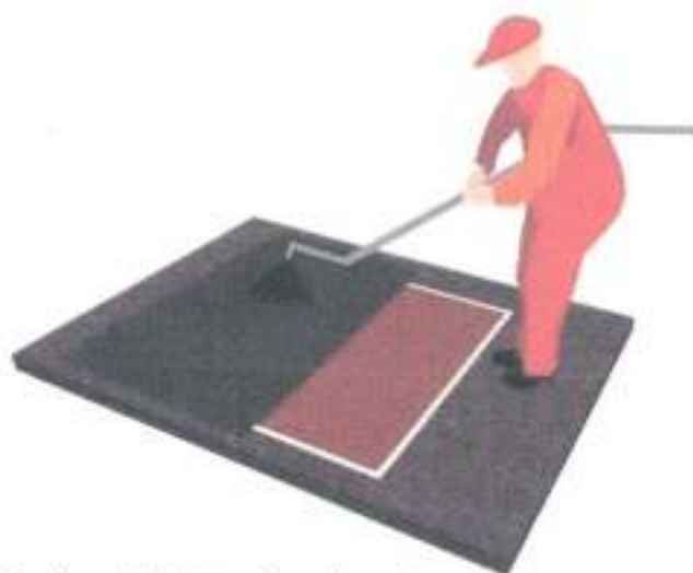
Figura 3 - Execução da pintura de ligação.
