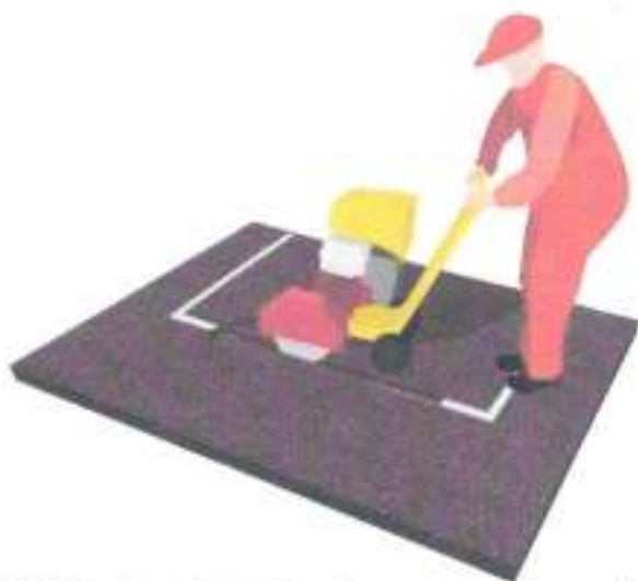
Figura 2 - Corte e remoção do revestimento asfáltico.
