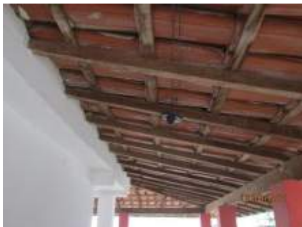
FIGURA 26 - ARMAZENAMENTO IRREGULAR DE RSS NO ESF-E (EXTENSÃO)
